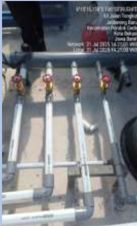
Pemasangan gate valve torn air ke lantai 3, lantai 2, lantai 1 dan dack torn atap
