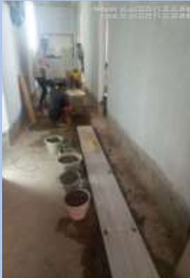
Pemasangan keramik/HT di lantai 2
